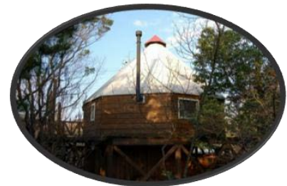
建設予定のパオ実物です
